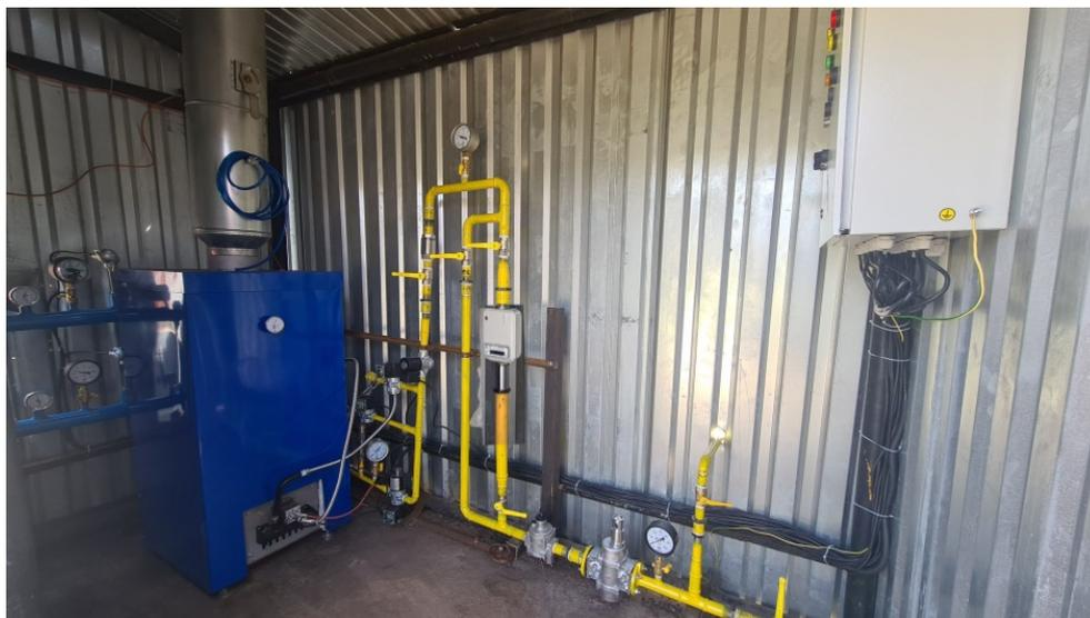
*Рис. 2.* Котел КВ-ЦБ на установке подготовки нефти
